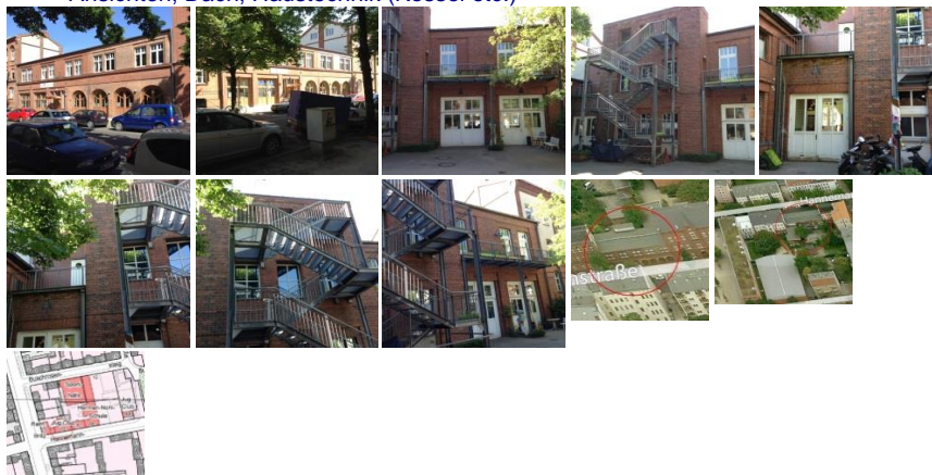
Ansichten, Dach, Haustechnik (Kessel etc.)
